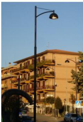
PALO CON SBRACCIO ED ARMATURA CUT OFF
