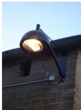
SBRACCIO A MURO CON ARMATURA CUT OFF
